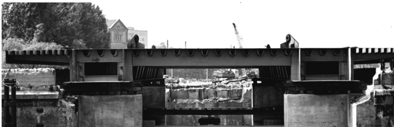
Rys.2 Sekcja środkowa przęseł mostu w trakcie budowy – 1988 [4]
