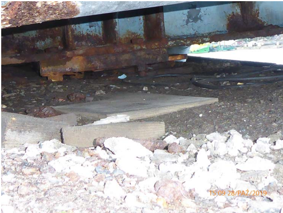
Rys. 12. Łożysko na przyczółku od strony Stogi – dolna woda. Przesunięcie przyczółka w stronę wody na łożysku wynosi ~180 mm
