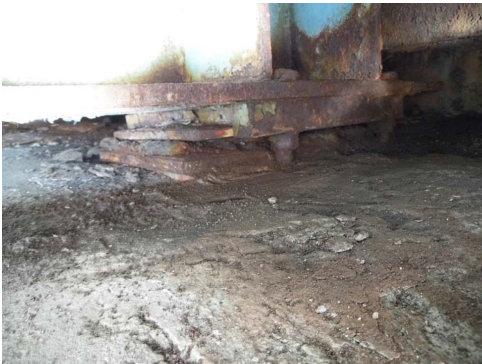
Rys. 12. Łożysko na przyczółku od strony Stogi – dolna woda. Przesunięcie przyczółka w stronę wody na łożysku wynosi ~180 mm
