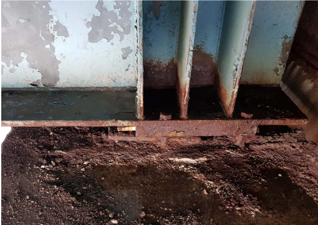
Rys. 10. Łożysko na przyczółku od strony Gdańsk – dolna woda. Przesunięcie przyczółka w stronę wody na łożysku wynosi ~164 mm
