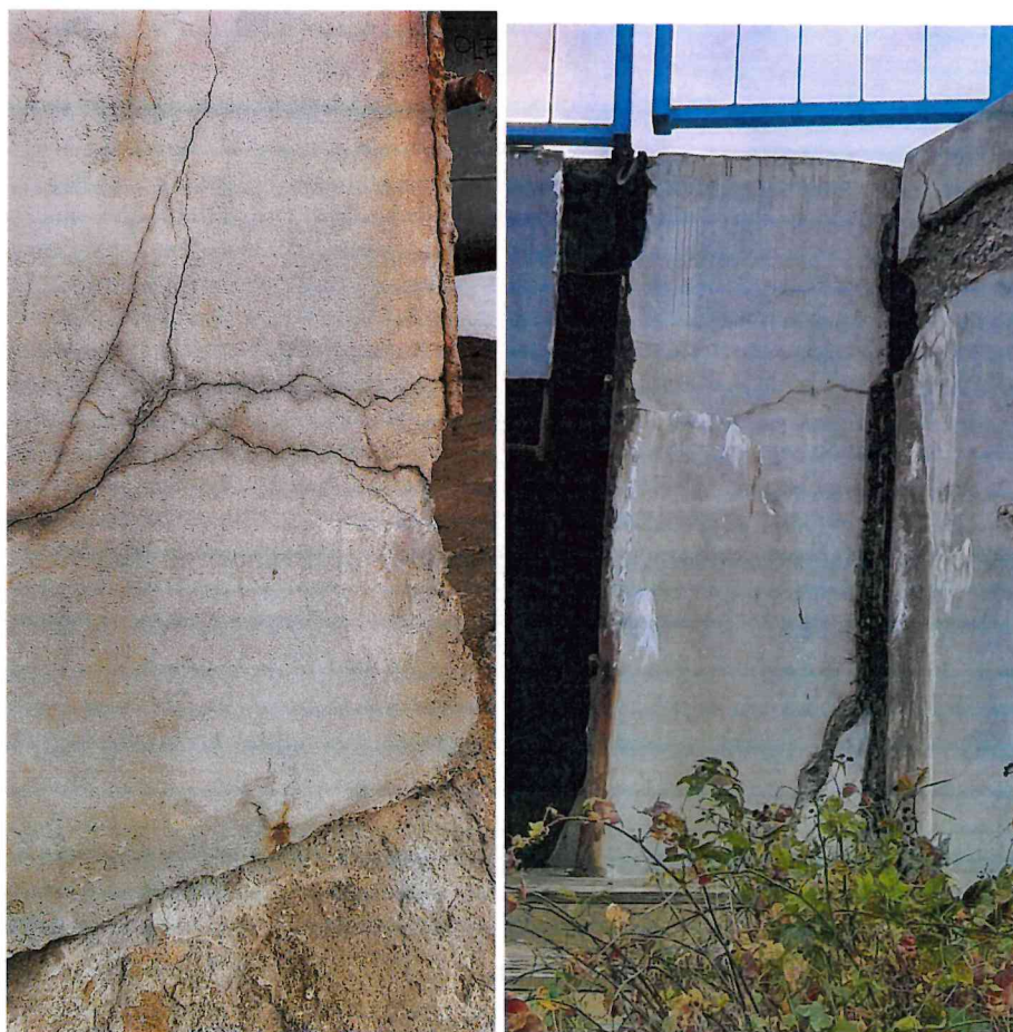
Rys. 6.1. Ścianki żwirowe (z lewej) od strony Stogów i od strony Gdańska
