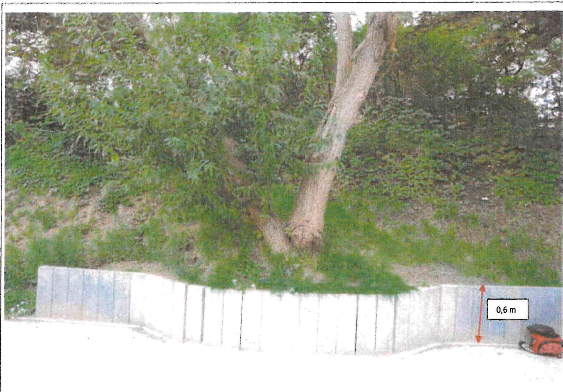
Widok podłoża i części odziomkowej. Widoczny murek oporowy po stronie ulicy
