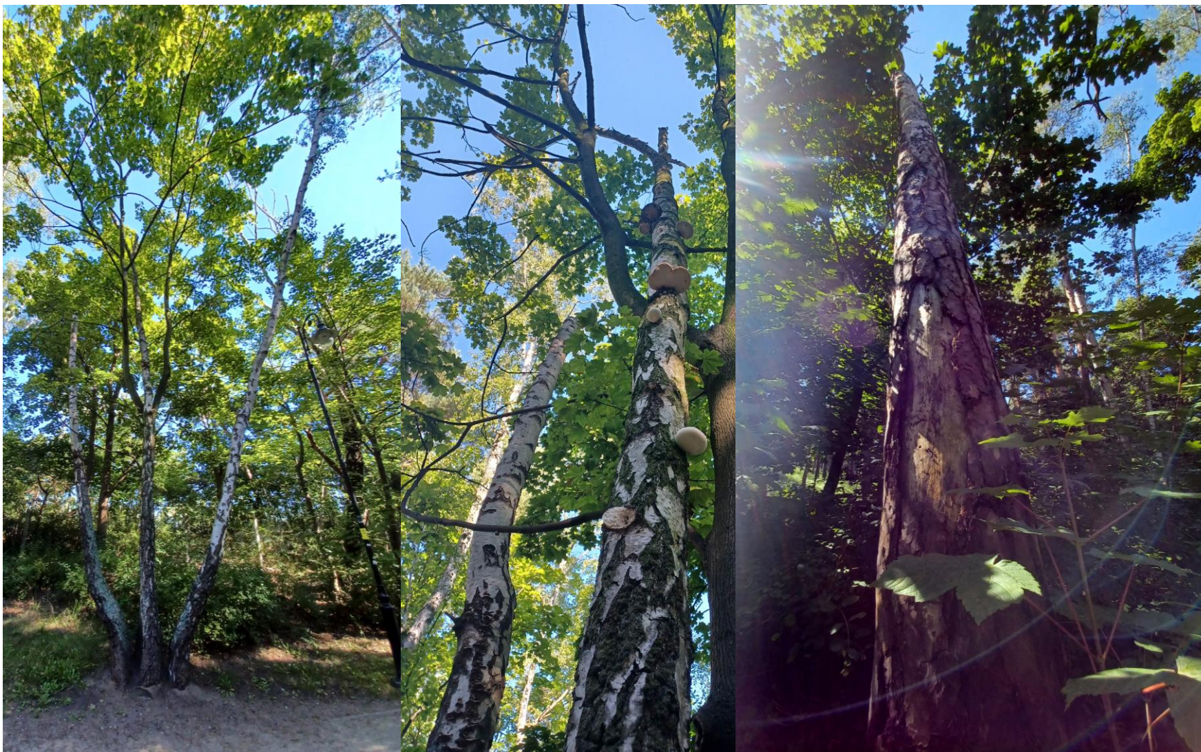
Fot. nr 36. Drzewo nr D37 – ogólna sylwetka drzewa, przewodniki drzewa z wylamaną częścią wierzchołkową Fot. nr 37. Drzewo nr D38 – pień drzewa
