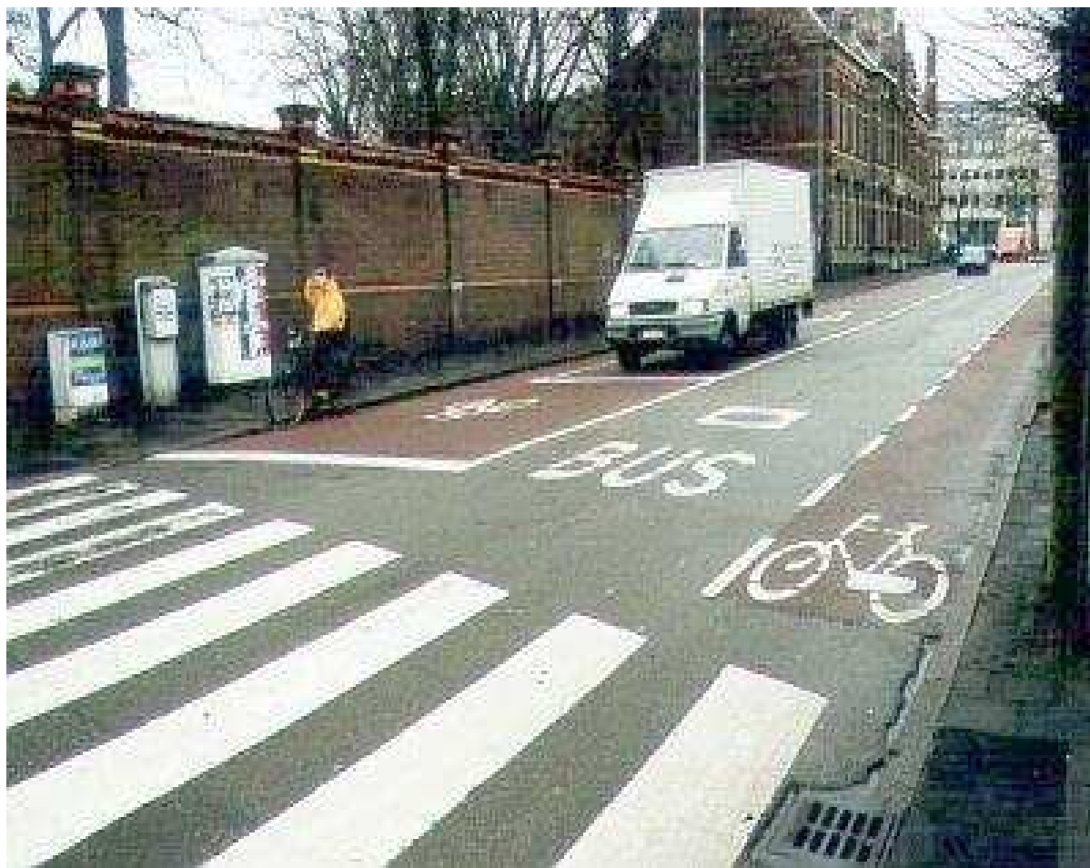
Rysunek 17 Przykład śluzy dla rowerów – przypadek 1 (niewłaściwie wbudowana kratka ściekowa)
