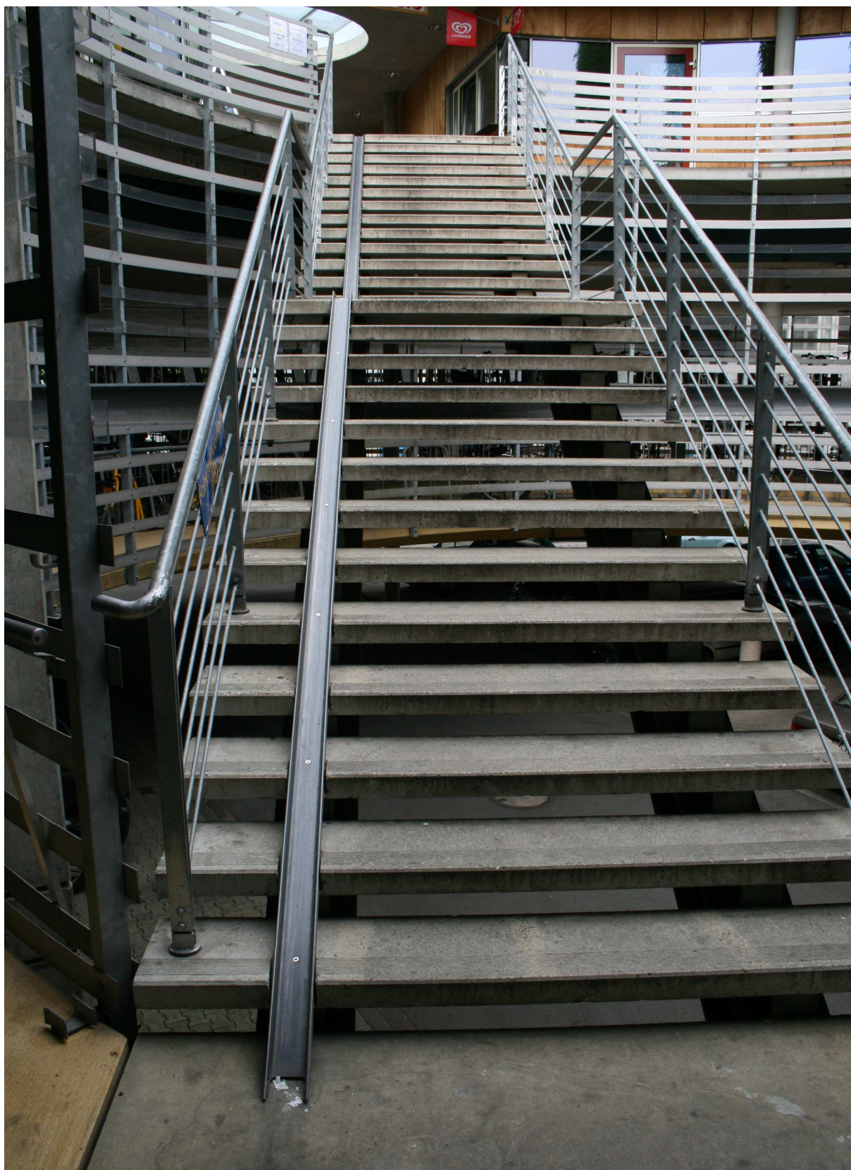
Rysunek 22 Rampa rowerowa na schodach
