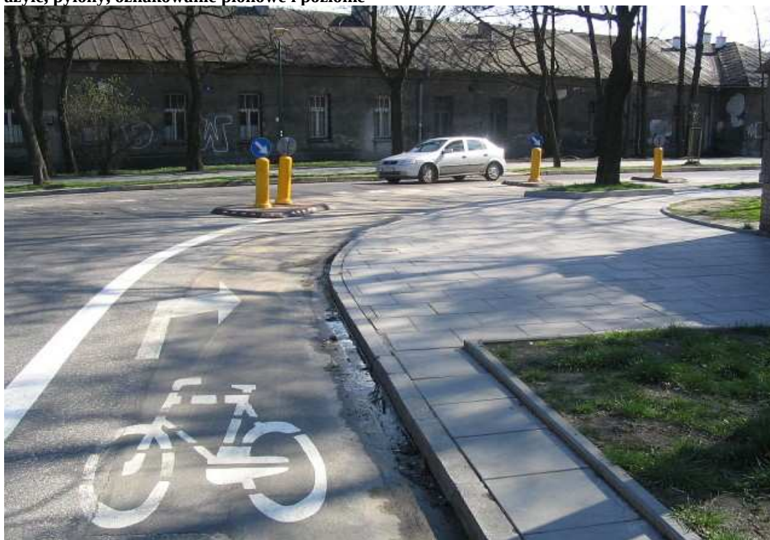
Rysunek 4 Kontrapas rowerowy w rejonie łuku poziomego – wysepki dzielące zabezpieczają rowerzystów przed ścinającymi zakręt samochodami
