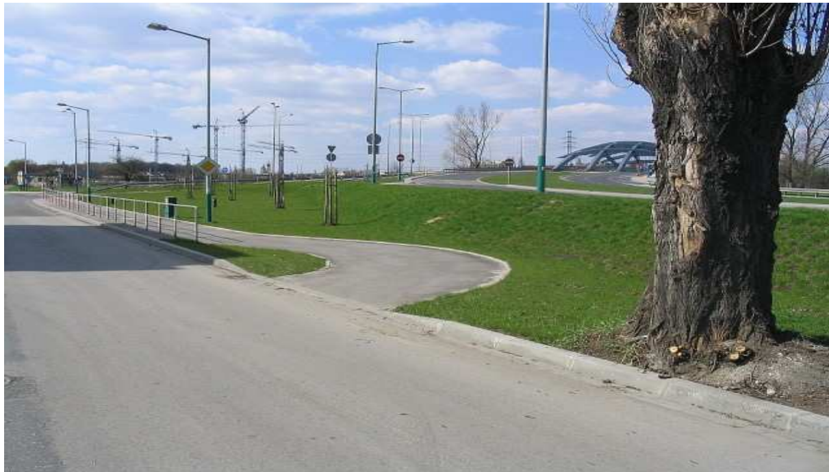
Rysunek 14 Nieprawidłowo zaprojektowany wjazd na drogę rowerową
