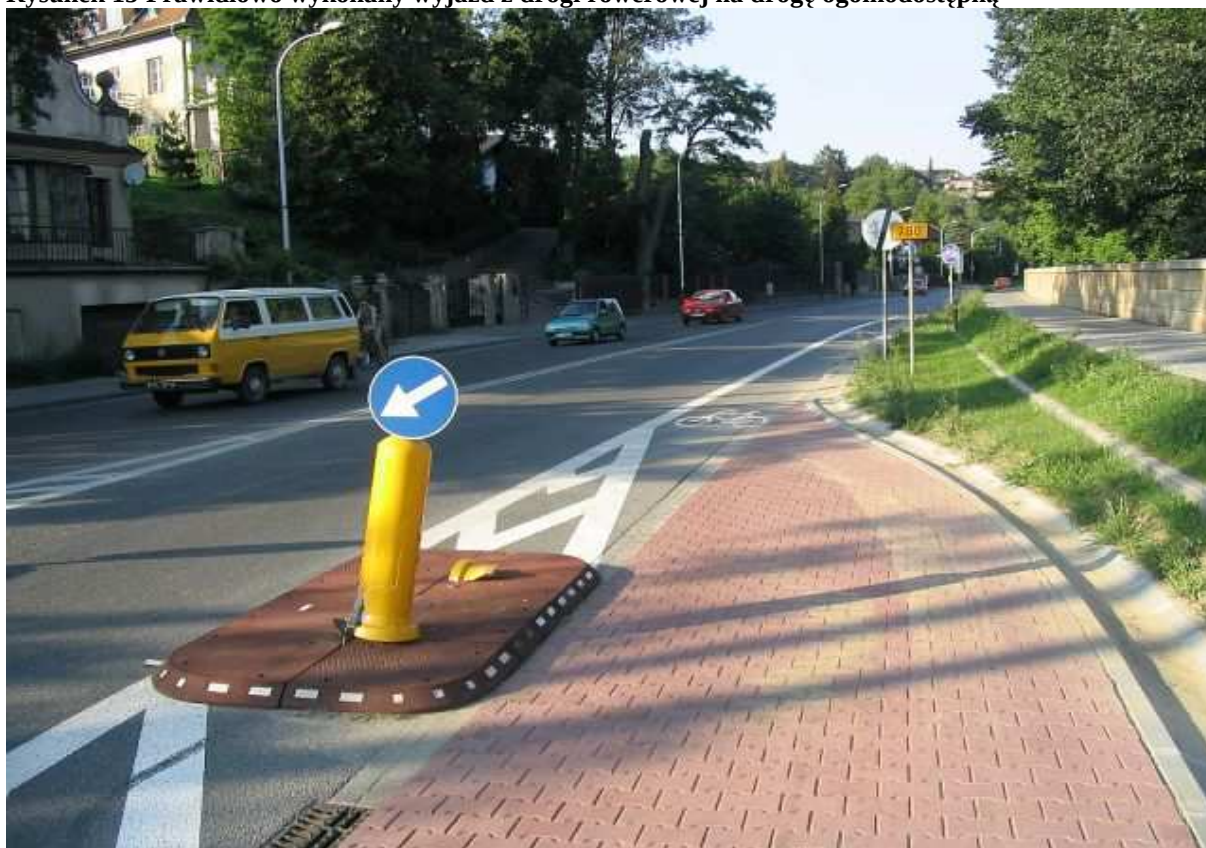
Rysunek 15 Prawidłowo wykonany wyjazd z drogi rowerowej na drogę ogólnodostępną
