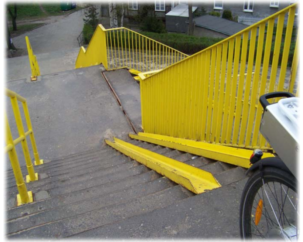
Zdjęcie 56 po lewej i zdjęcie 57 po prawej: Rynny na kładce nad Traktem Św. Wojciecha przy stacji PKP i SKM Gdańsk Orunia źródło: zdjęcie wykonane przez Magdalenę Jasiak
